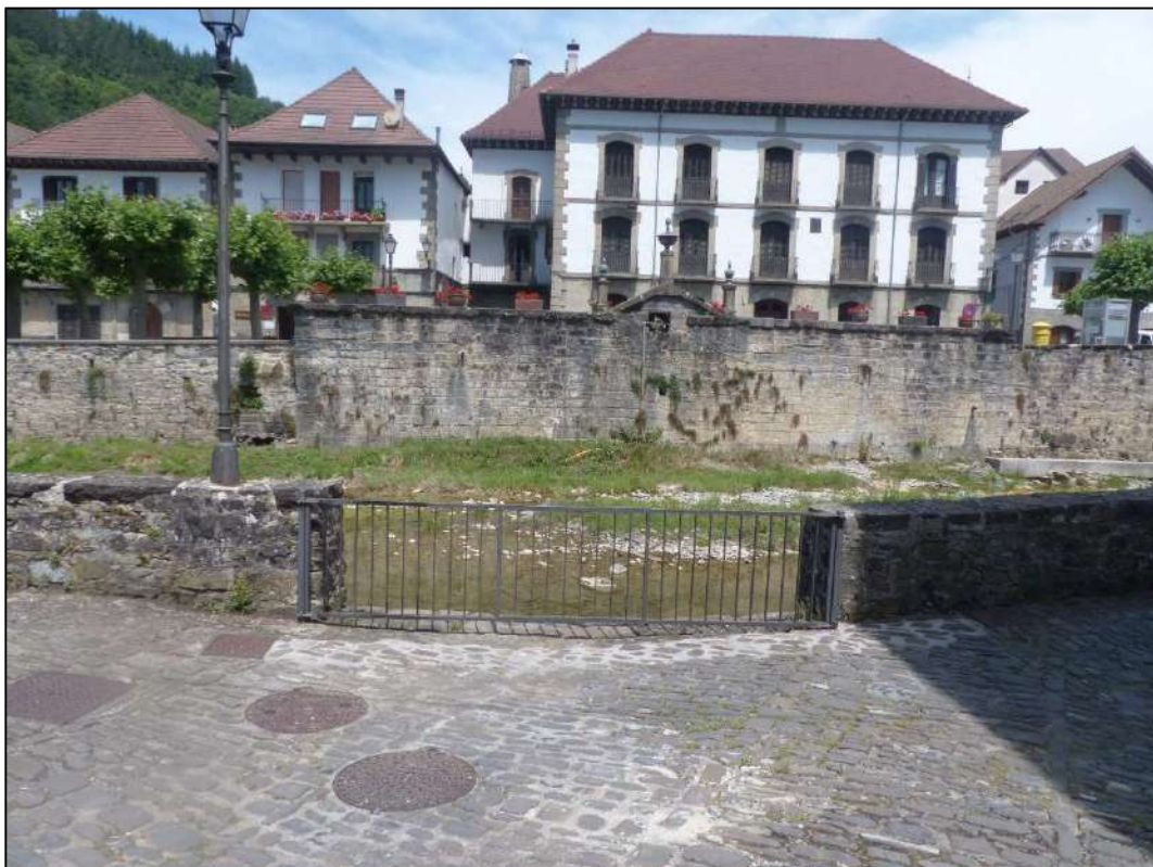
Figura 38. Vista del cuarto y último puente sobre el Anduña en Ochagavía. La segunda fotografía muestra también uno de los puntos más bajos de la calle en la margen izquierda del río, por el que pueden iniciarse los desbordamientos.
