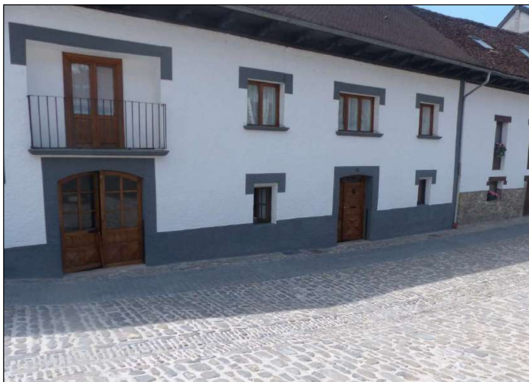
Figura 35. Vistas del primer puente – de un total de cuatro puentes – sobre el río Anduña en el casco urbano de Ochagavía. Se trata del primer puente aguas arriba. Vistas también de las casas afectadas por los desbordamientos en este punto, concretamente en la margen izquierda del río.
