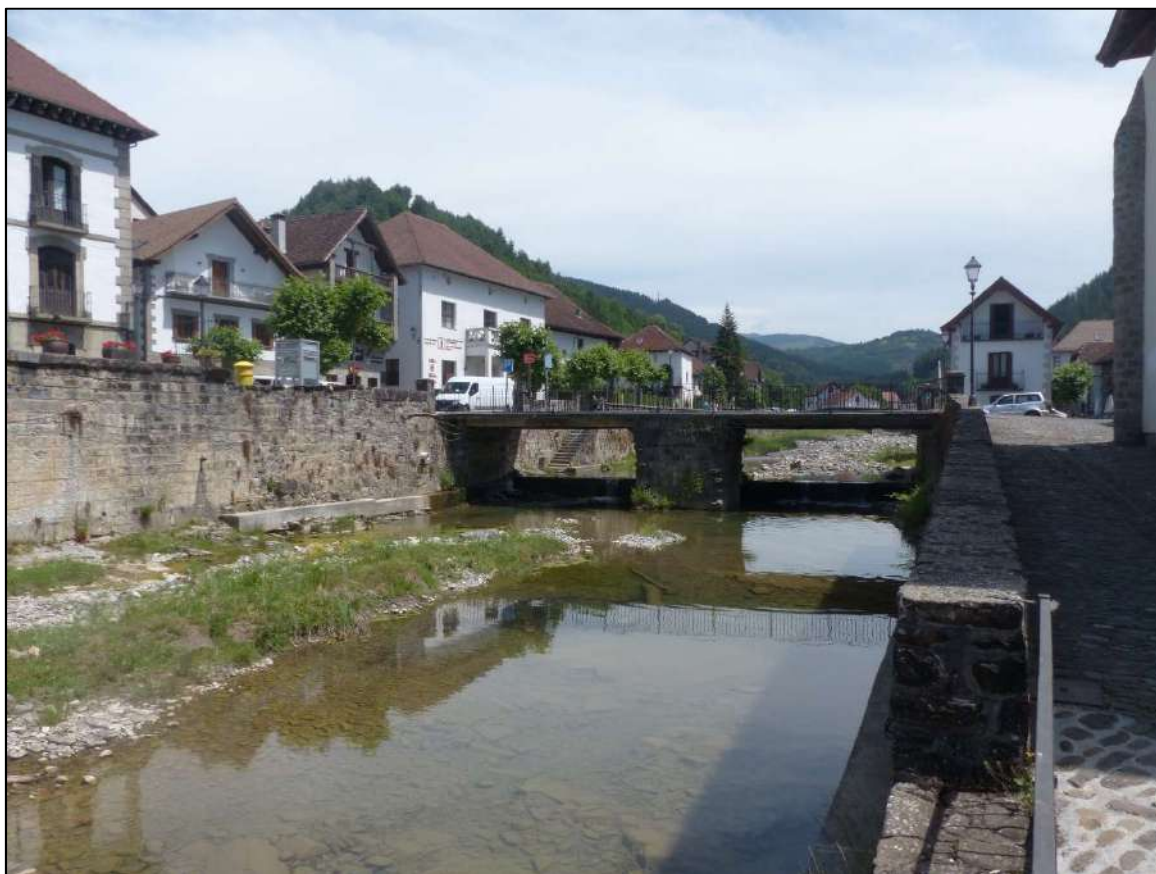
Figura 37. Imágenes del tercer puente sobre el Anduña, así como imágenes de los puntos críticos de desbordamiento del río en este tramo [hueco en las paredes del encauzamiento y rampa de acceso al cauce].
