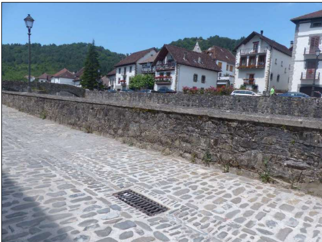
Figura 36. Vistas del segundo puente sobre el río Anduña en la localidad, y fotografía de los puntos más bajos de inicio de la inundación en la margen izquierda del río en este tramo.
