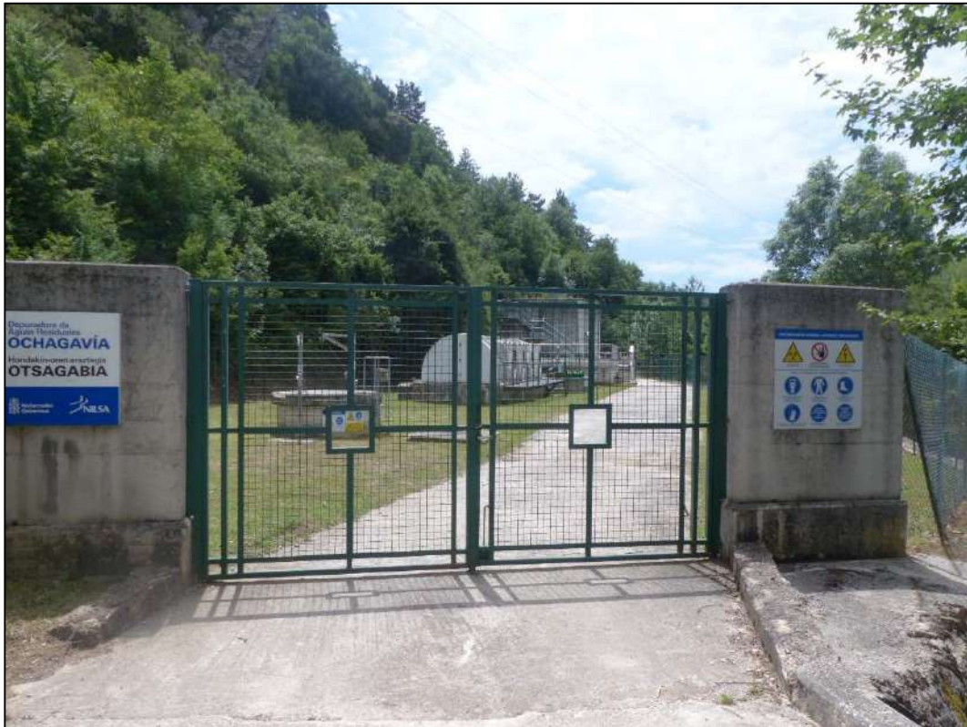
Figura 41. Imagen del punto de acceso a la EDAR de Ochagavía. La EDAR está situada también en la margen izquierda del río Salazar y justo aguas abajo del puente que da acceso al camping de Osate desde la carretera NA-140.
