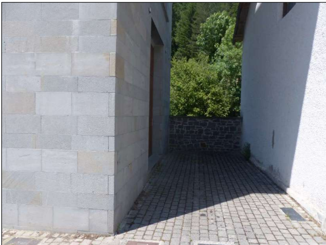
Figura 39. Fotografías tomadas en los márgenes del río Zatoia, a su paso por el casco urbano de Ochagavía.
