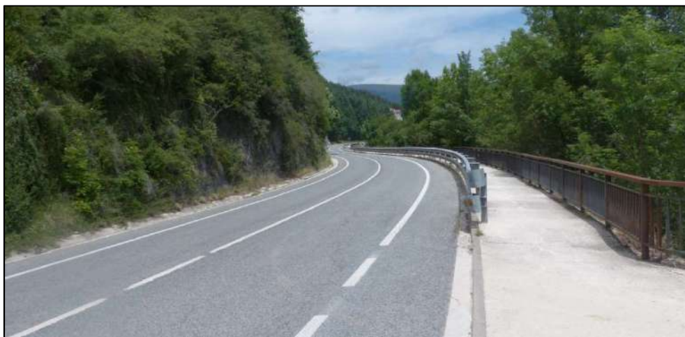
Figura 23 Fotografía de la carretera NA-140. En concreto la fotografía muestra el tramo de carretera que resultaría anegado en esta zona para inundación asociada a un periodo de retorno de 100 años.
