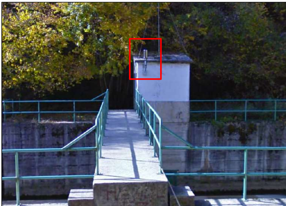
Figura 12 Ubicación de la estación meteorológica que tiene el Gobierno de Navarra instalada en su estación de aforo del río Zatoia en Ochagavía.
